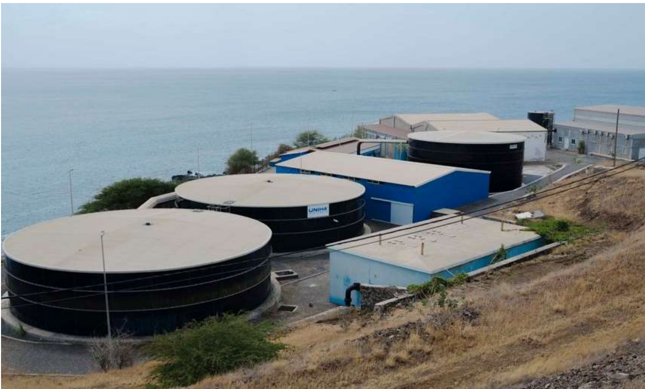
UNIHA Meerwasserentsalzungsanlage bei Praia Foto: Carmen Abd Ali / DER SPIEGEL
